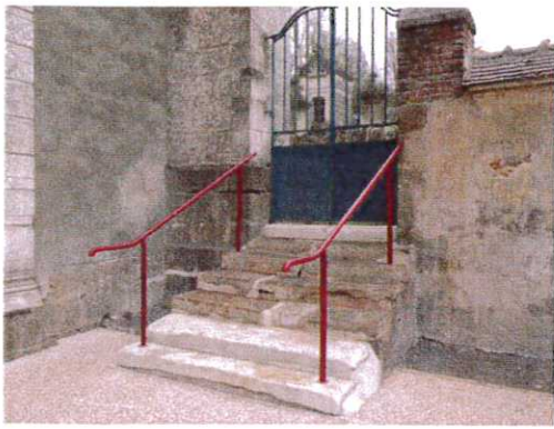
Pose de mains courantes sur les marches de l'église dans le cadre de l'Ad'ap
