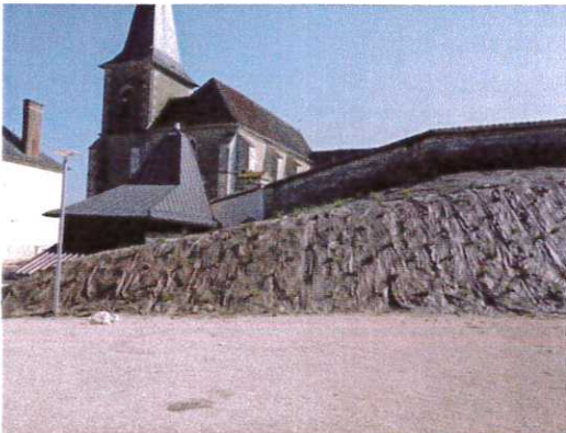
Plantation espace chaufferie
