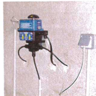
Chloration : installation des vannes
